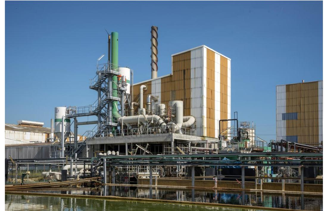
GalliCam évite une étape énergivore des procédés actuels, qui consiste à fabriquer les sulfates de nickel comme produit intermédiaire. De plus, avec un fort taux de recyclage interne de l'eau et des réactifs, le volume de déchets est minimisé. L'effluent principal sera de la même composition que l'eau de mer.
